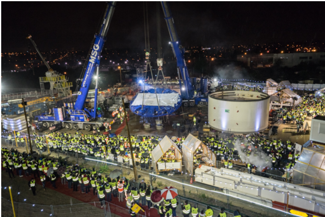
Baptême de Steffie Orbival, premier tunnelier du Grand Paris express, le 3 février 2018 à Champigny. © Jgp
